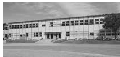
仮設校舎の外観
